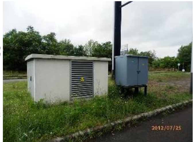
Transzformátor és mérőóra
