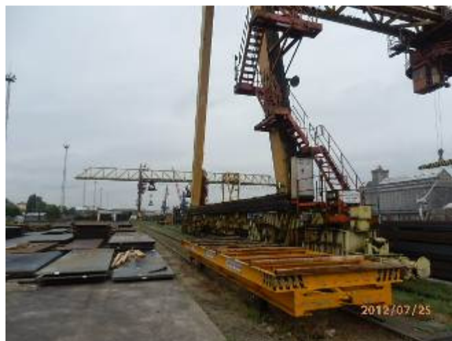
40 tonnás daruk az épülete kívül
