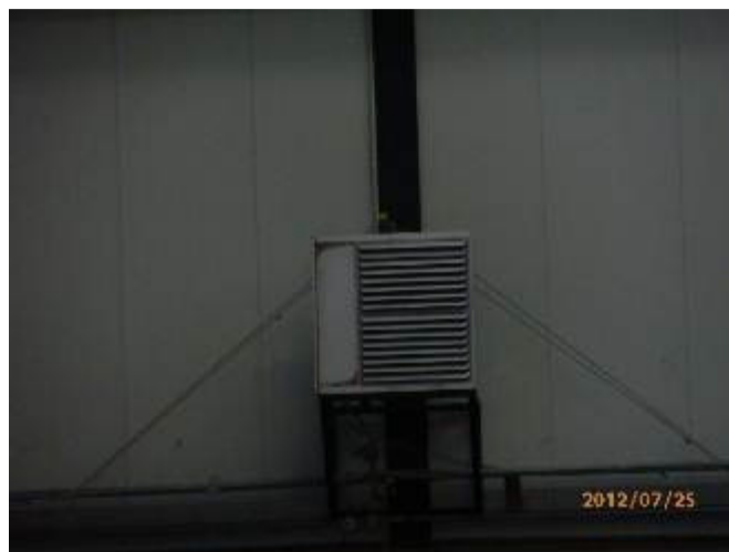
Fűtési rendszer, sugárzó
